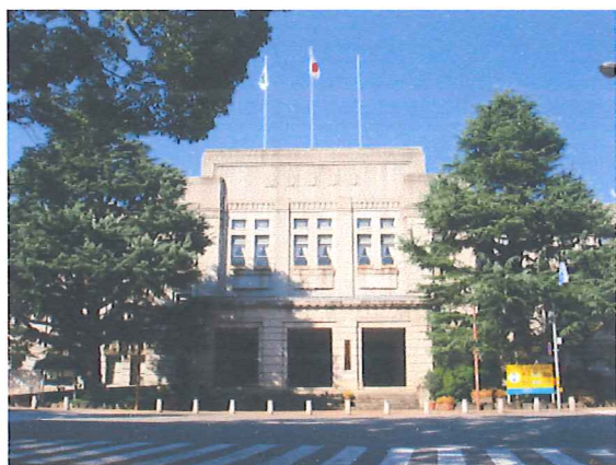
図2-4 第2代岐阜県庁舎(現岐阜総合庁舎)
