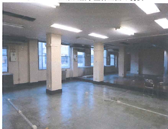
図 3-31 旧議場（柱を追加し 3 階の床スラブが増築されている）
