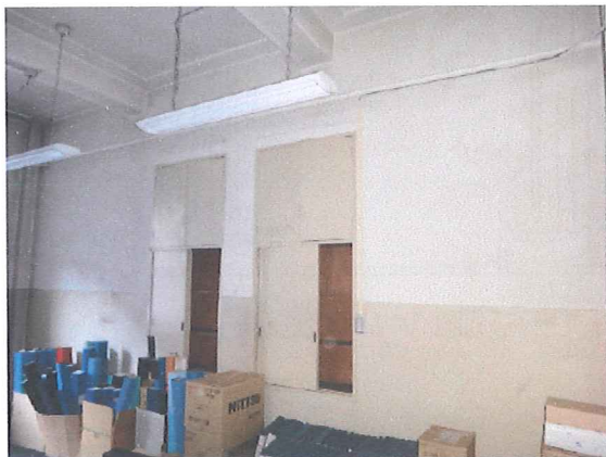
図3-33 収納として利用されている開口部
