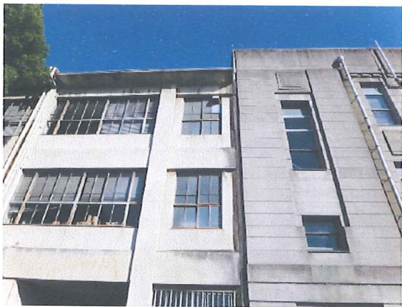
図 3-29 西面、増築部（左側）との連結箇所
