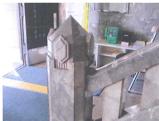
図 3-50 玄関ホール階段親柱
